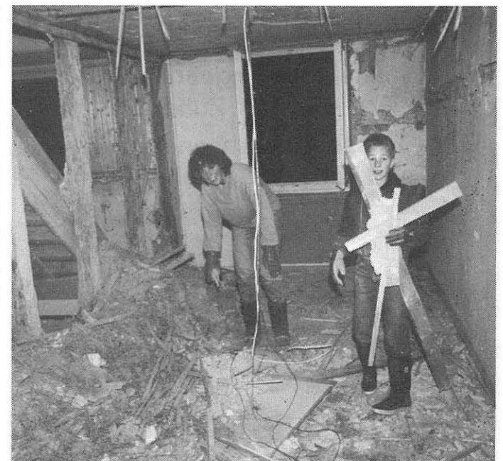
Beim Herausreissen der alten Wände helfen alle mit
