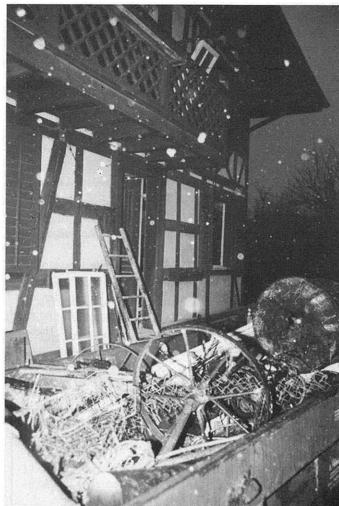
Winterlicher Umbau im Bauernhaus des Pestalozzihauses
