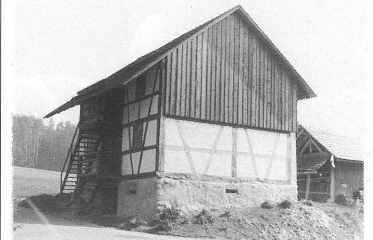
Spicher Elsau nach der Renovation
