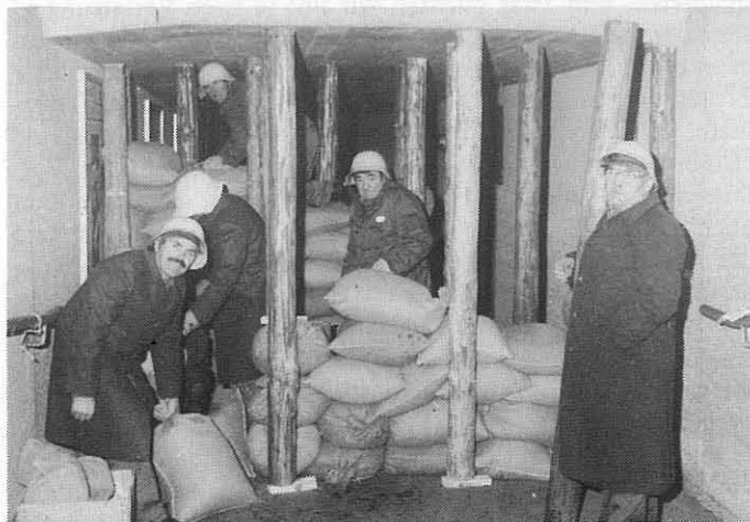
Hier wird kein Grotto eingerichtet, sondern Notschutzmassnahmen (Splitterschutz) der Bahnhofunterführung ausgeführt.
