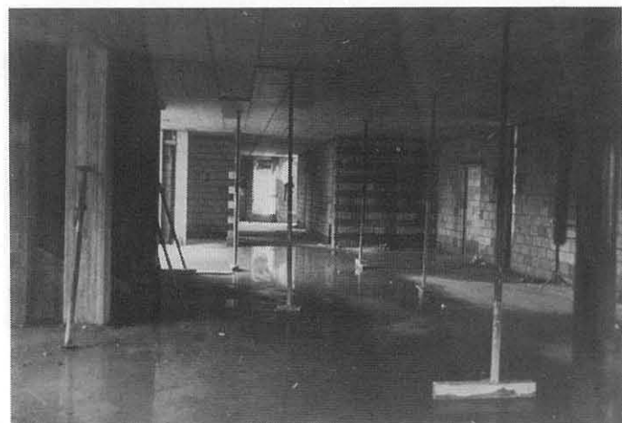
Blick vom Singsaal durch die Eingangshalle (Anfang Okt. 84)
