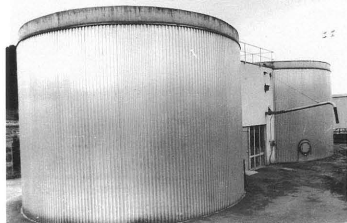
Einer der Faultürme
