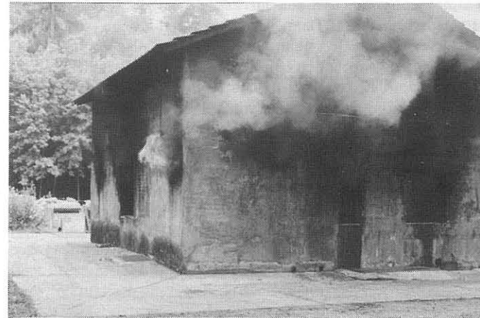
„Vonlanten-Strasse 8 – Brandausbruch mit starker Rauchentwicklung“
