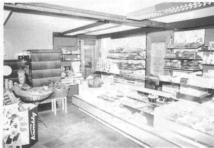
Die Bäckerei Sommer an der Elsauerstrasse 20 nach dem Umbau
