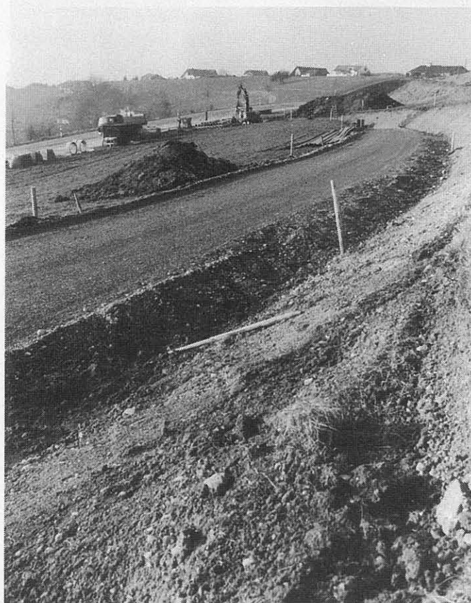
Bereits erschlossen präsentiert sich das Bauland in der Egg, wo nun die ersten Baugespanne ausgesteckt werden.
