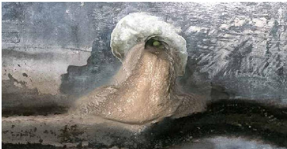
Ein gängiges Bild aus der Elsauer Kanalisation: Eine Meteorwasserleitung mündet direkt in einer Schmutzwasserleitung. Das heisst, dass das eigentlich saubere Meteorwasser anschliessend in die ARA geleitet und dort gereinigt wird.
