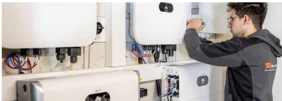
Halle durften die Spezialisten der Heinz Schmid AG kürzlich eine neue Photovoltaikanlage installieren (168 Module, 382m<sup>2</sup> Fläche, 69.72kWp Leistung). In Kombination mit dem 30kWh Batteriespeicher können die jährlichen Energiekosten um 30% reduziert werden.
